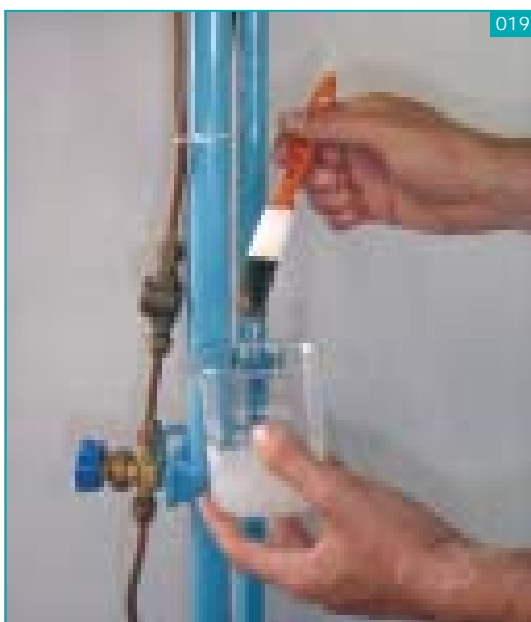
Detectar vazamento com detergente líquido
