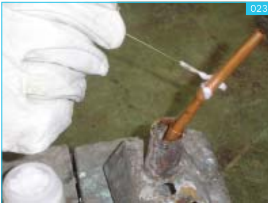
● Aplicação de fluxo nos tubos
