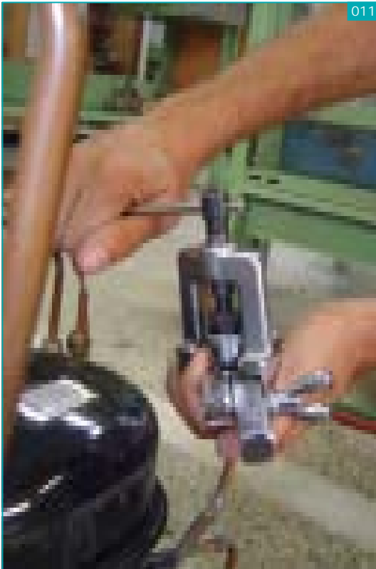
Preparo de conexões e Flangeamento
