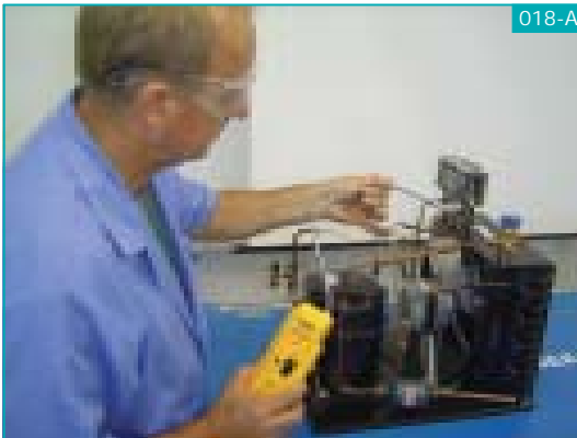
Detectar vazamento com detector eletrônico
