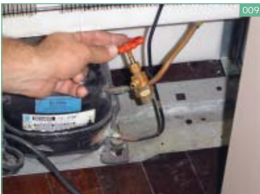
Instalar válvula de perfuração no tubo de processo do compressor
