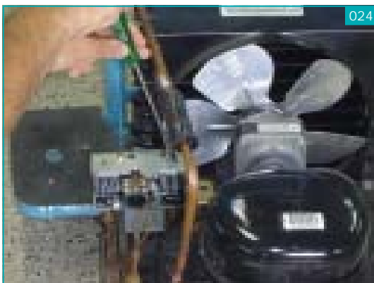
Ajustar Pressostato de alta e baixa pressão
