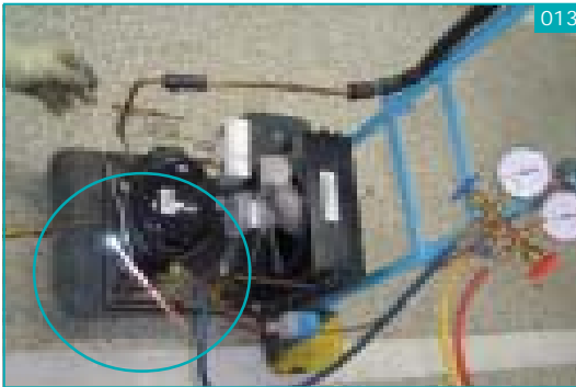
Soldando conexão com circulação de Nitrogênio
