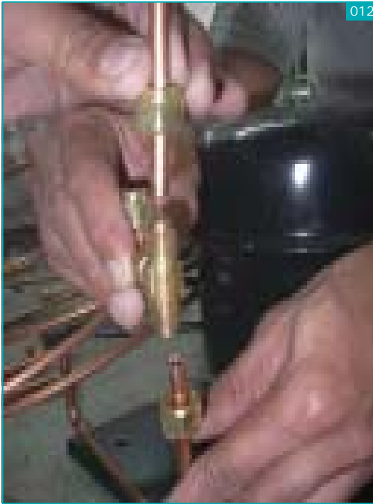
Conectar as conexões de serviço
