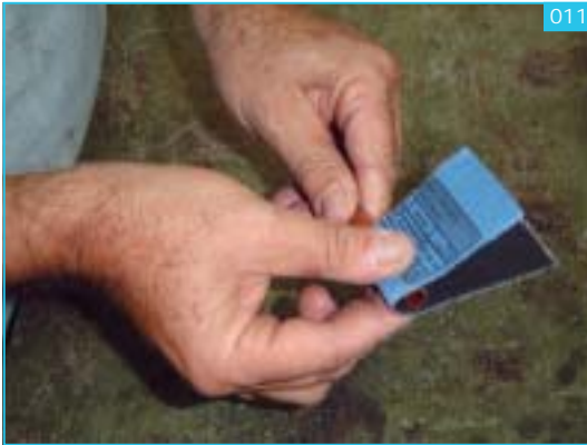
Limpar o tubo utilizando lixa
