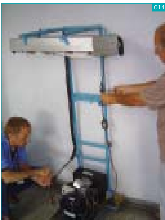
Montagem do visor de líquido e Pressostato
